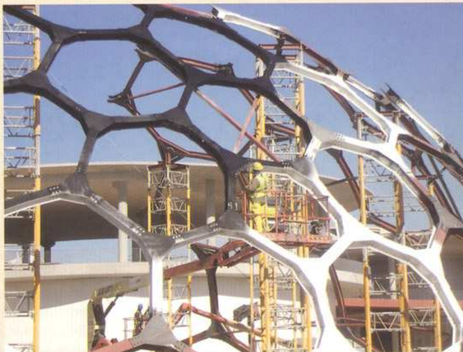
Aplicación de pintura especial en uno de los pabellones de la Expo de Zaragoza.
