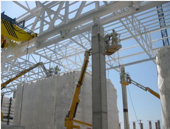
Operarios de UNISERSA realizando trabajos de ignifugación en las obras de la desaladora de Torrevieja.
